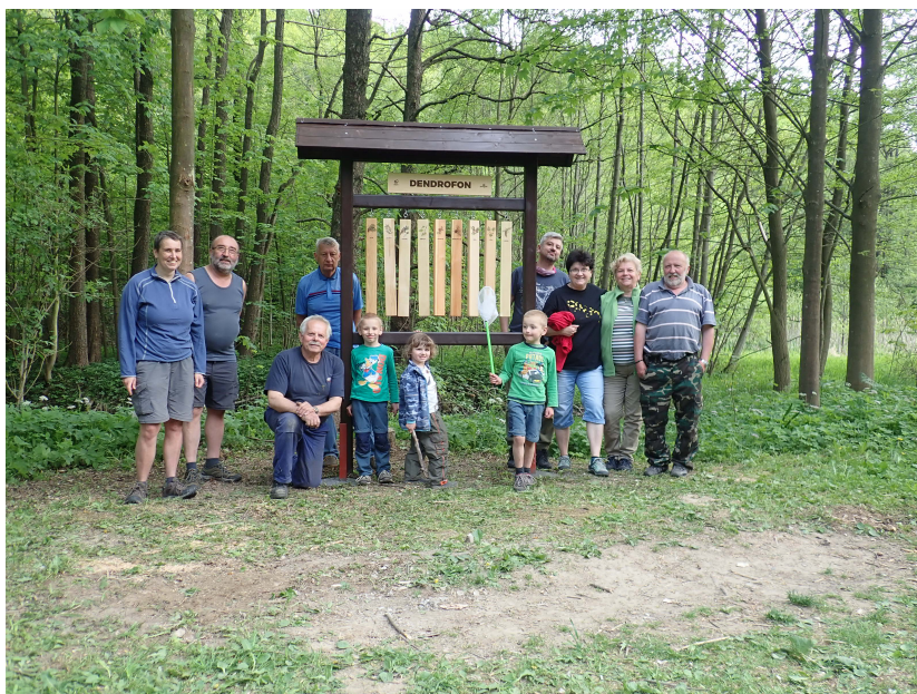
Oprava herního prvku Dendrofon
