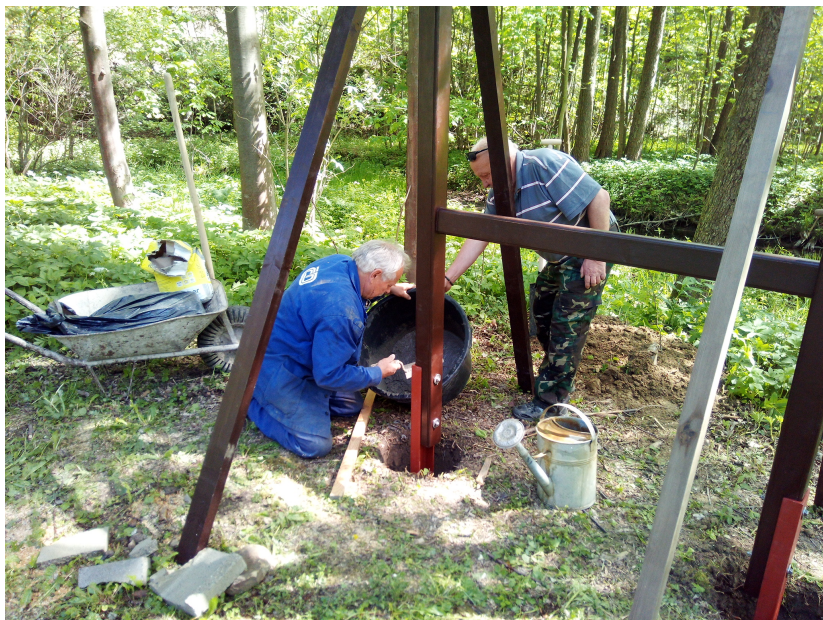
Oprava herního prvku Dendrofon
